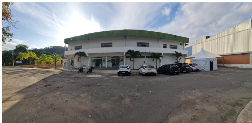
Figura 5. Foto da fachada do prédio do Campus Avançado Ubá.
