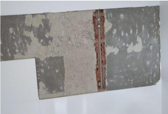
Demolição azulejo para detecção obstrução tubo hidrául.
