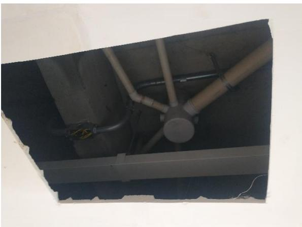
Abertura forro de gesso para detecção vazamento cx sifonada
