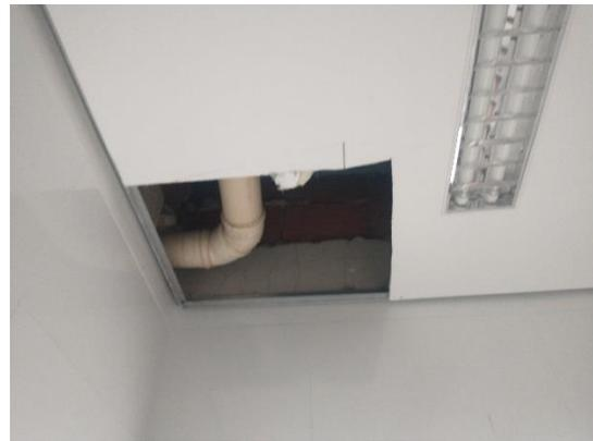
Abertura de forro detecção de vazamento tubo esgoto
