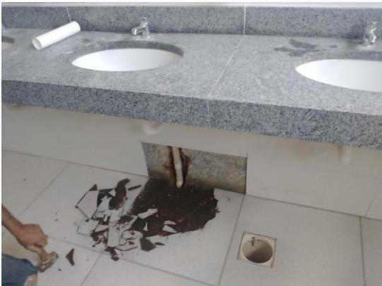
Emenda de tubulação dentro da parede sem vedação
