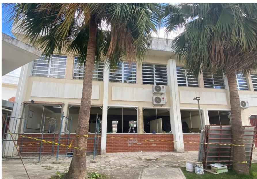
Registro Fotográfico nº 14 – Assentamento de contramarco das janelas do 1º pavimento e instalação das novas janelas do 2º pavimento do bloco A.
