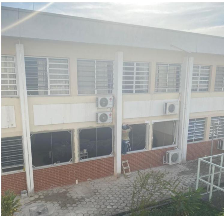
Registro Fotográfico nº 18 – Assentamento de contramarco e instalação das janelas do 1º pavimento do bloco B.
