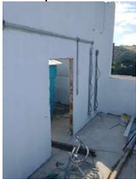
2- Consta na planilha porta de 60cm de madeira semi oca para a área de DML no térreo. Local sem nenhuma proteção das chuvas, nesta condição vai comprometer sua vida útil da porta e guarnição. sugerimos a substituir por uma porta de alumínio tipo veneziana.
