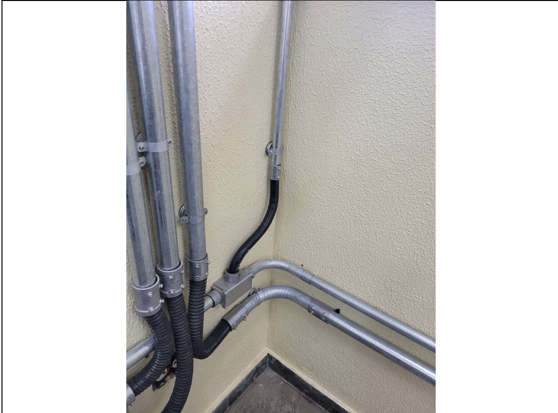
NOVO 05 - ELETRODUTO FLEXÍVEL, EM AÇO GALVANIZADO, REVESTIDO EXTERNAMENTE COM PVC PRETO (1.1/4")
