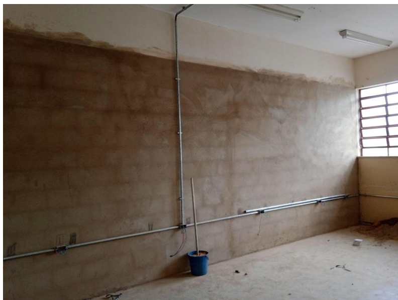
Registro Fotográfico nº 10 – Execução do reboco da parede de alvenaria da sala 206 e início da instalação da infraestrutura elétrica
