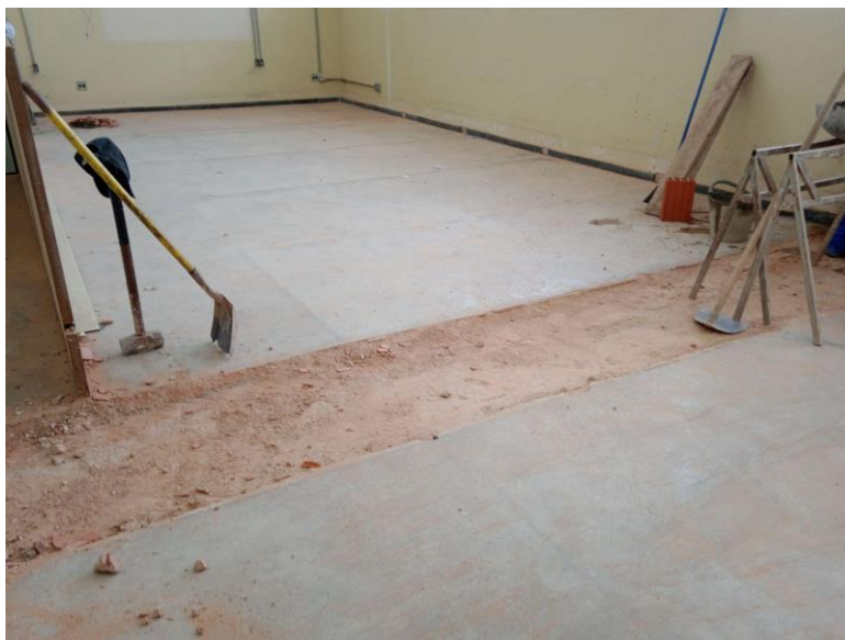
Registro Fotográfico nº 15 – Retirada de entulhos da demolição da parede da nova sala 201 para posterior finalização do piso
