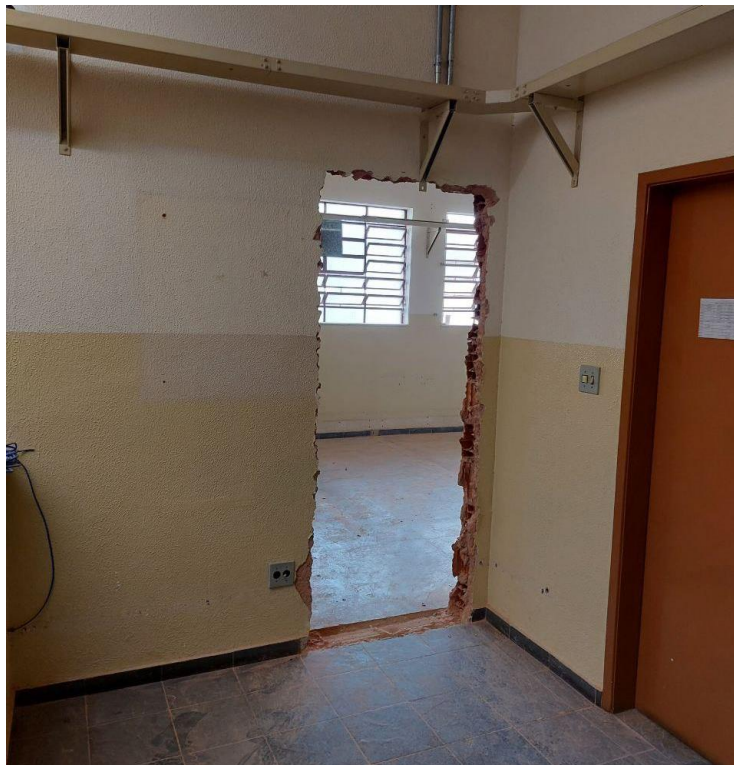
Registro Fotográfico nº 09 – Corte na alvenaria para instalação de porta na futura sala de professores
