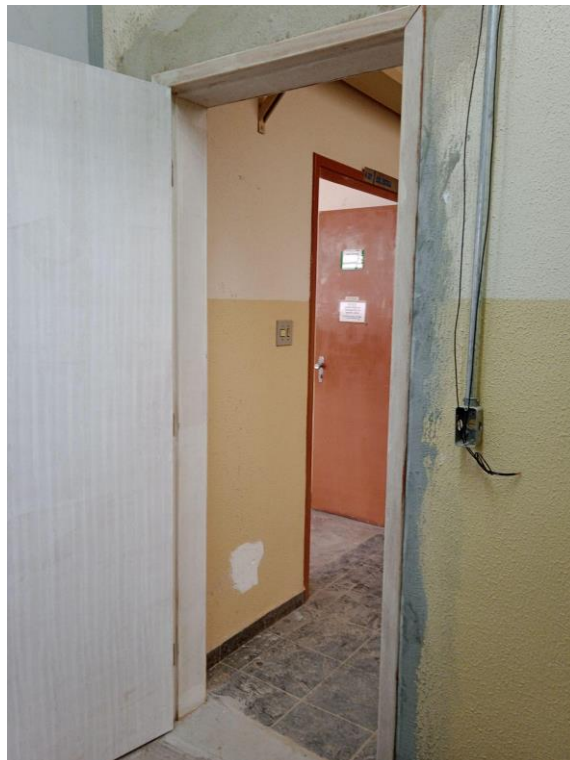
Registro Fotográfico nº 19 – Instalação da porta da nova sala de professores e início das instalações elétricas do comando de iluminação
