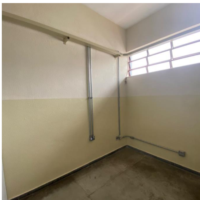
Registro Fotográfico nº 35 – Finalização das instalações elétricas e de cabeamento da sala de professores
