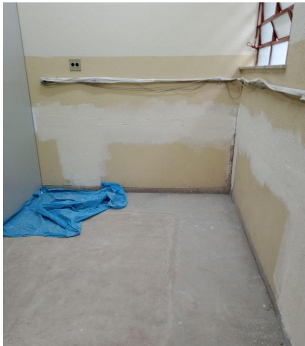
Registro Fotográfico nº 21 – Acabamento na parede da sala 202-B (pós retirada de bancadas)
