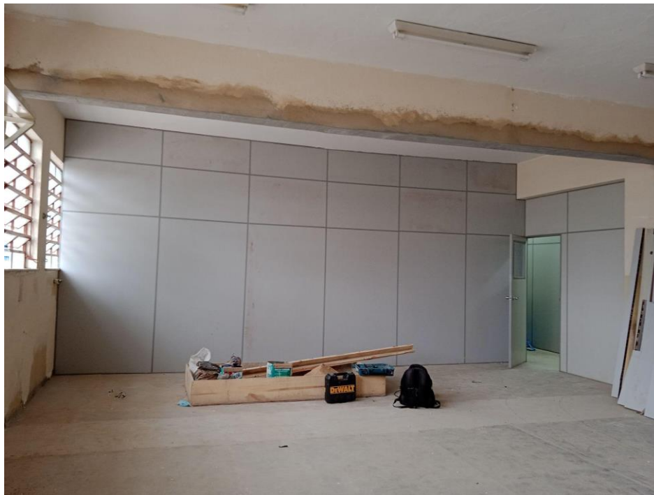
Registro Fotográfico nº 17 – Acabamento no piso da sala 201
