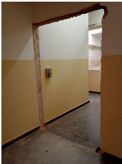
Registro Fotográfico nº 06 – Retirada da porta da sala de aula 205
