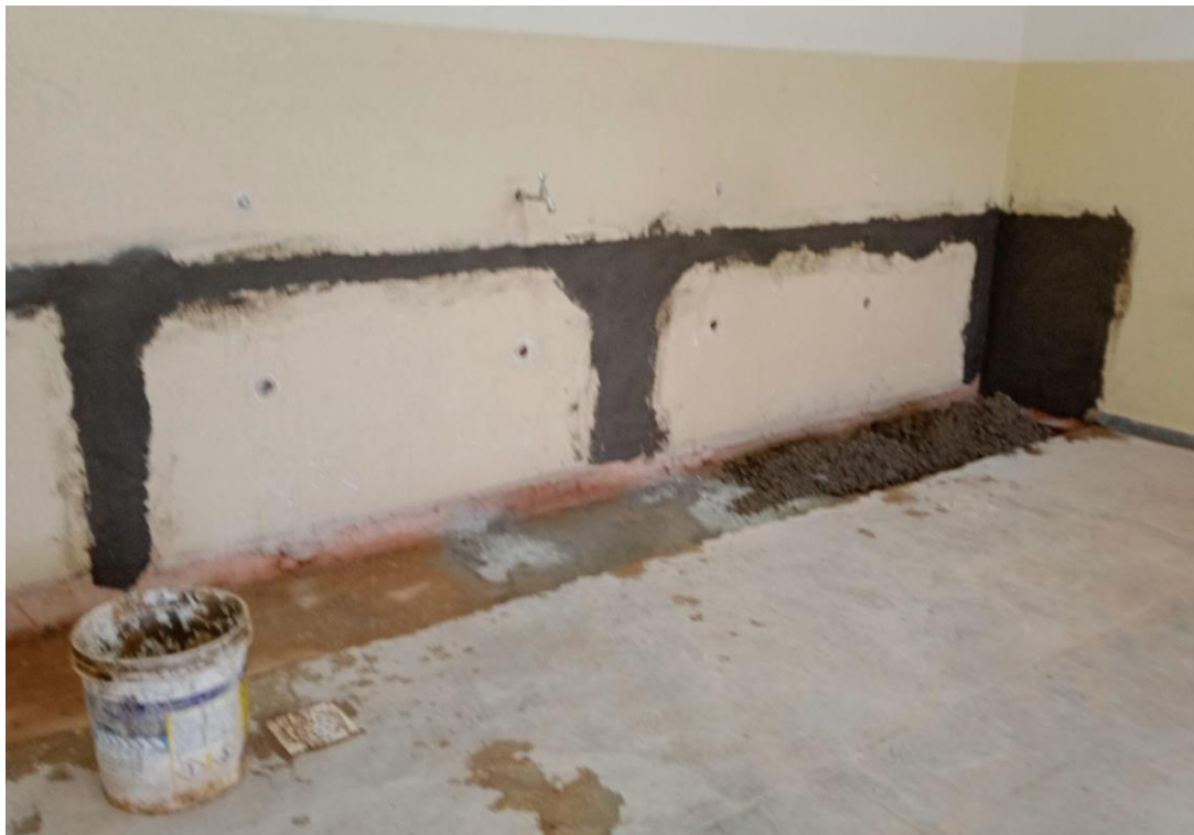
Registro Fotográfico nº 13 – Acabamento na parede da nova sala 206-B (pós retirada de bancadas)
