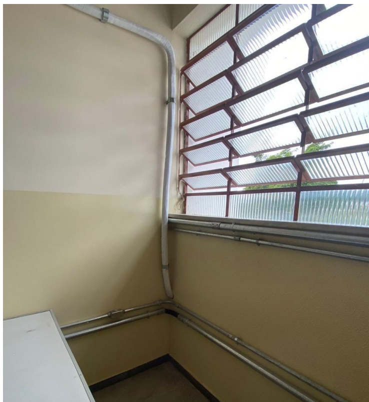
Registro Fotográfico nº 29 – Instalação do duto do aparelho de ar condicionado da sala 206-A
