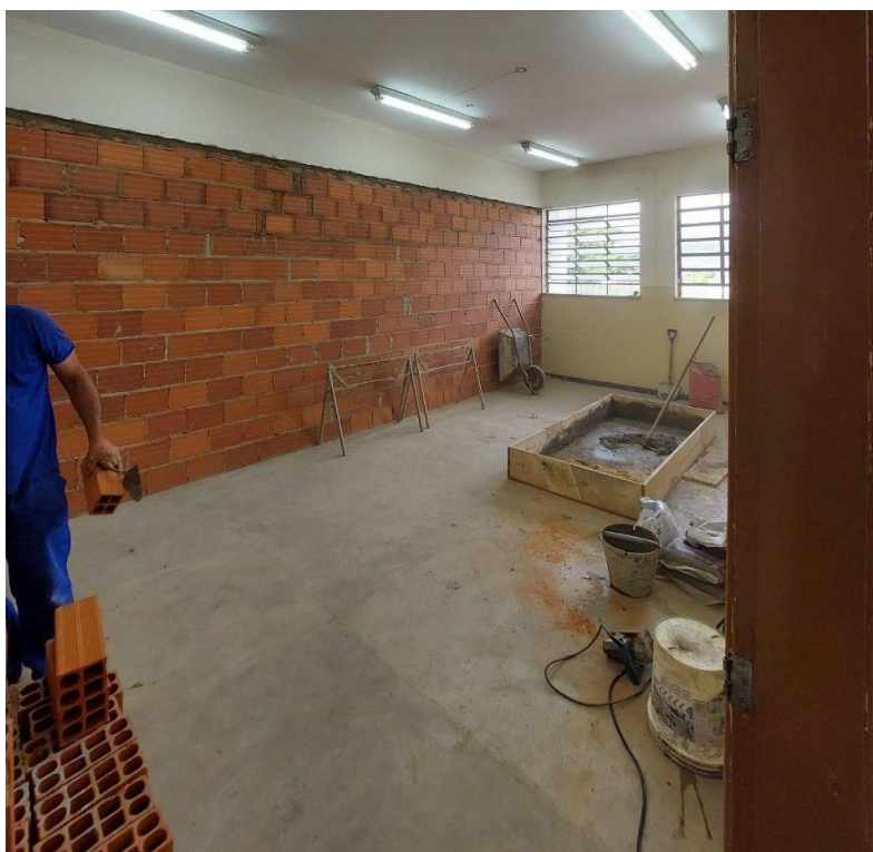
Registro Fotográfico nº 08 – Início da construção da parede de alvenaria na sala 206
