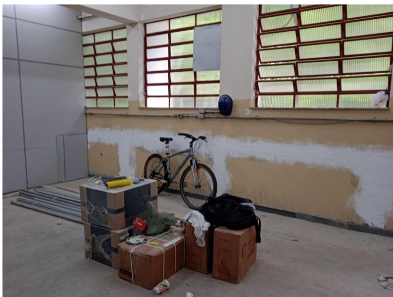
Registro Fotográfico nº 20 – Acabamento na parede da sala de aula 202-A (pós retirada de bancadas)
