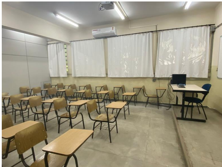
Registro Fotográfico nº 38 – Finalização do acabamento na parede e na divisória da sala 202-A
