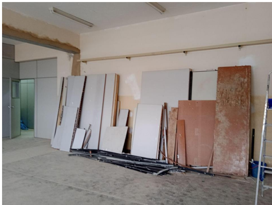
Registro Fotográfico nº 18 – Retirada das divisórias internas da sala 201
