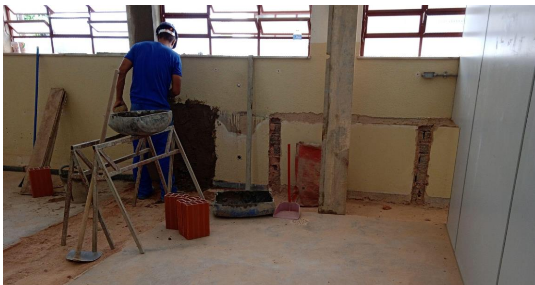
Registro Fotográfico nº 14 – Acabamento na parede da nova sala 201 (pós retirada de bancadas)
