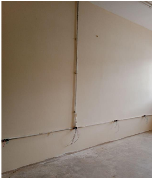
Registro Fotográfico nº 25 – Acabamento e pintura da parede da sala 206-A e início da instalação das tomadas
