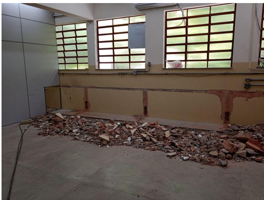
Registro Fotográfico nº 02 – Demolição de bancada na sala de aula 202-A
