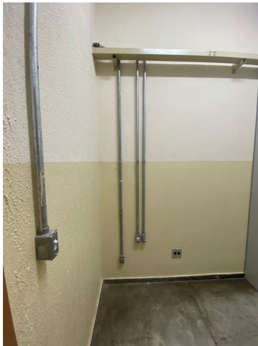
Registro Fotográfico nº 34 – Finalização das instalações elétricas e de cabeamento da sala de professores
