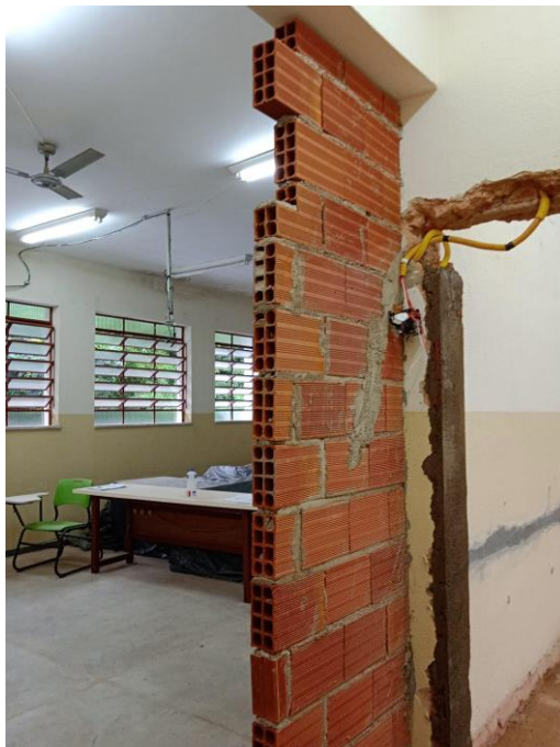
Registro Fotográfico nº 11 – Construção de parede de alvenaria para instalação de nova porta para sala de aula 205
