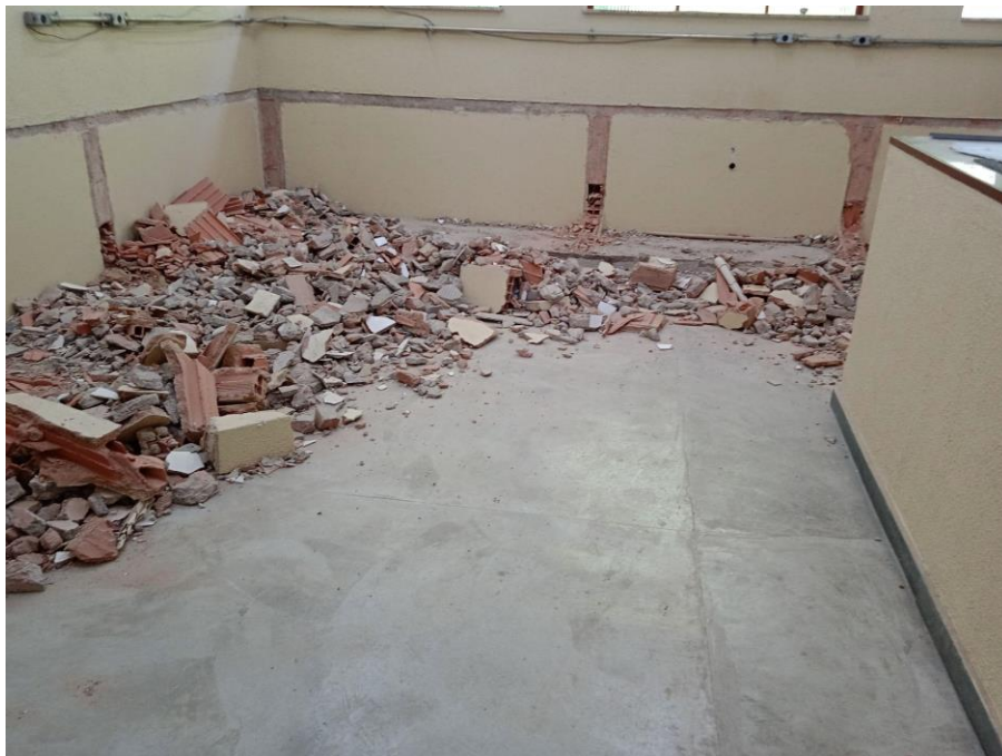
Registro Fotográfico nº 03 – Demolição de bancada na sala 202-B (Sala de bolsistas)
