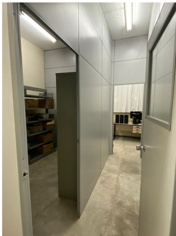
Registro Fotográfico nº 39 – Finalização da instalação das divisórias da sala 202-B
