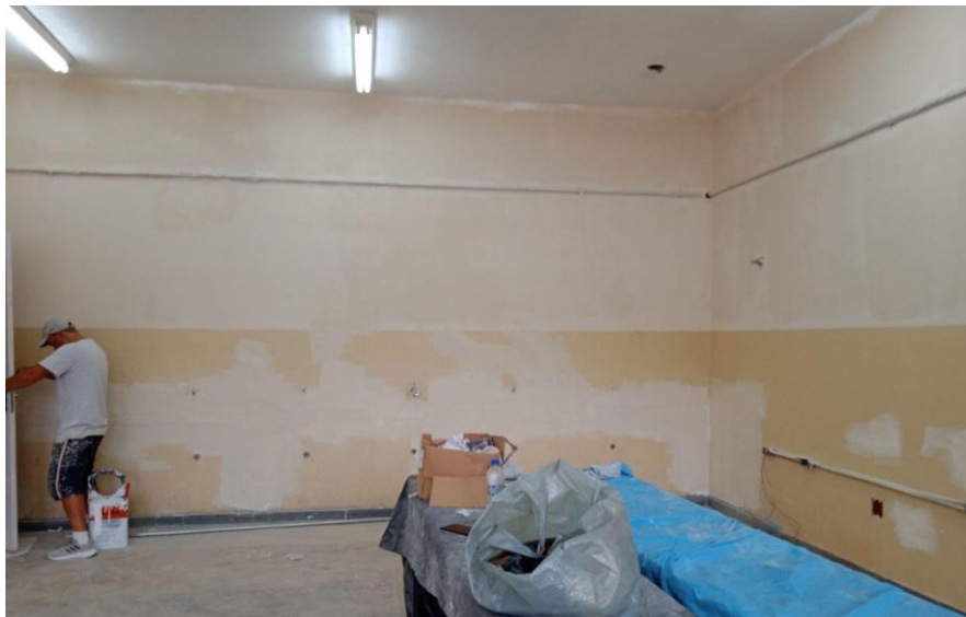
Registro Fotográfico nº 23 – Acabamento na parede da sala 206-B (pós retirada de bancadas) e início das instalações elétricas das tomadas
