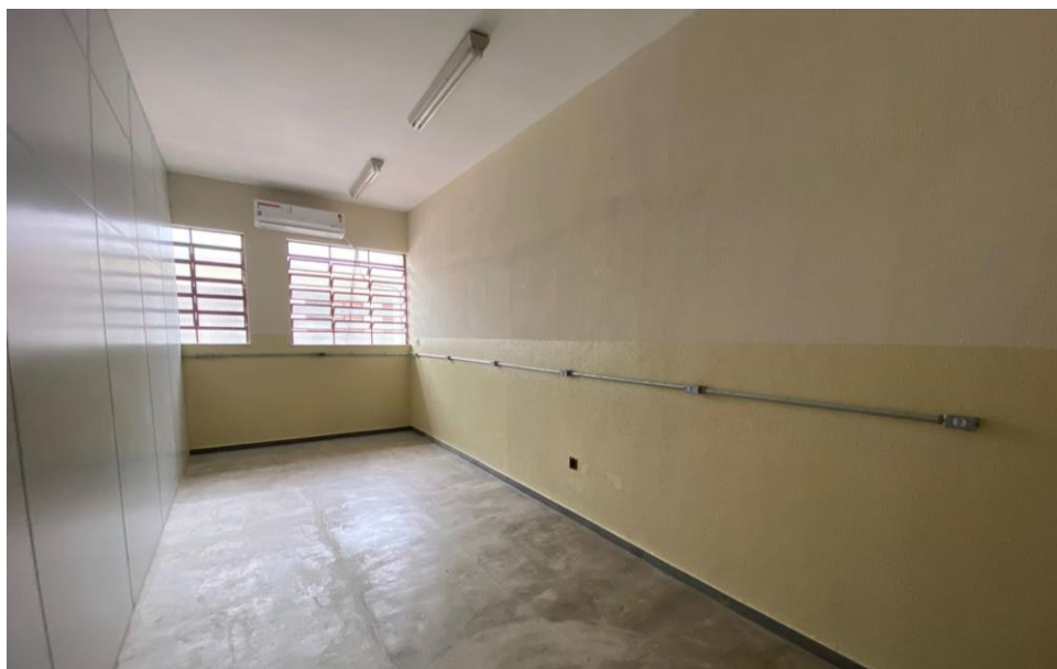
Registro Fotográfico nº 37 – Finalização das instalações elétricas da sala 202-C
