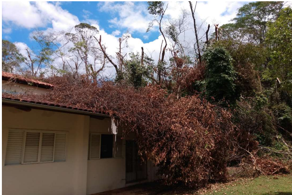
Foto 4 – Telhado do laboratório de agroindústria
