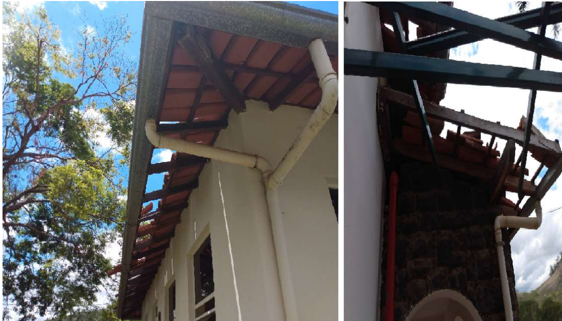
Foto 3 – Beiral e telhado do refeitório
