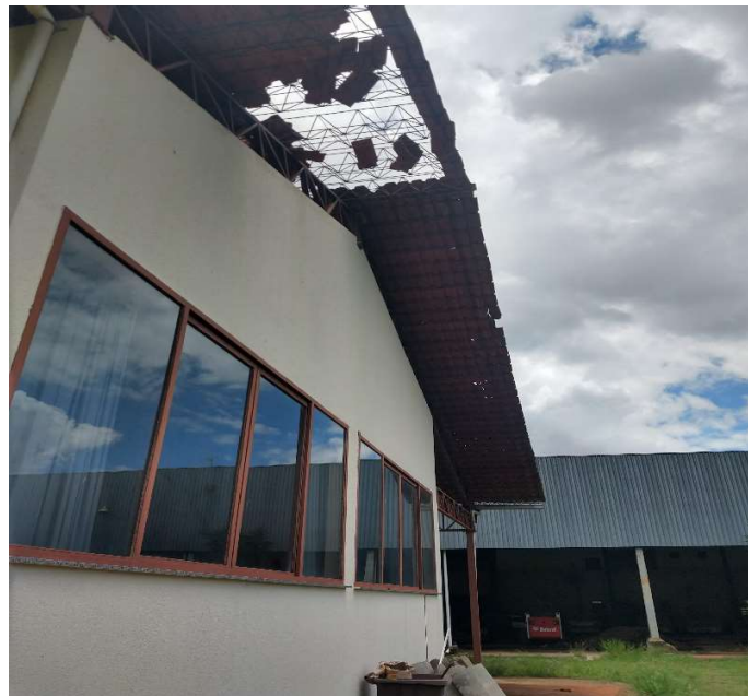
Foto 8 – Telhado do galpão de máquinas
