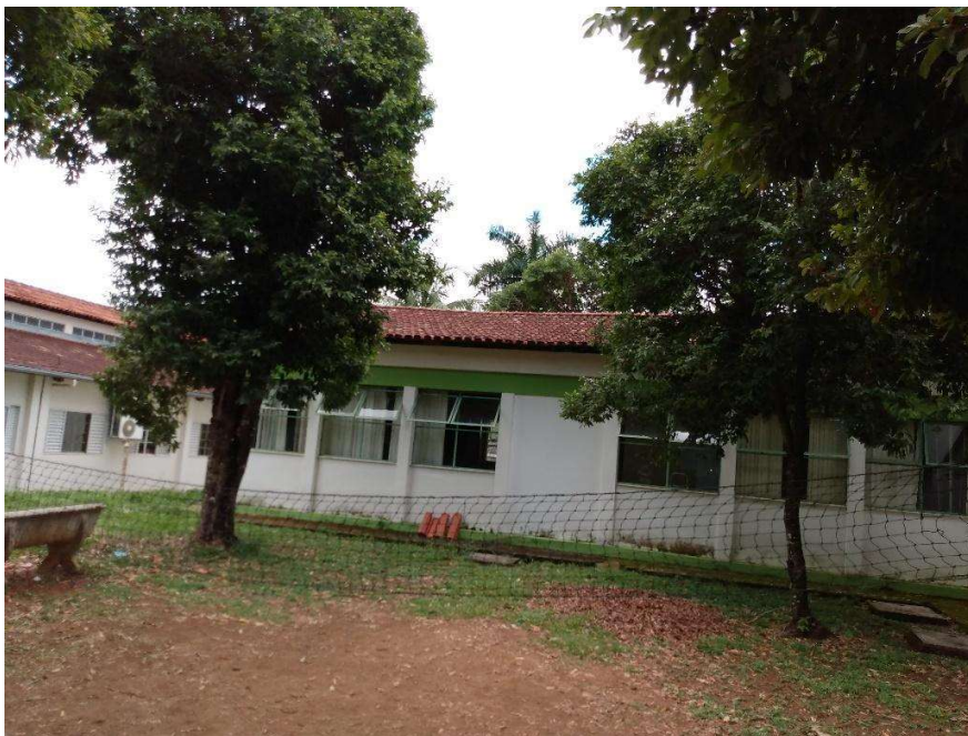
Foto 9 – Telhado da cobertura auditório
