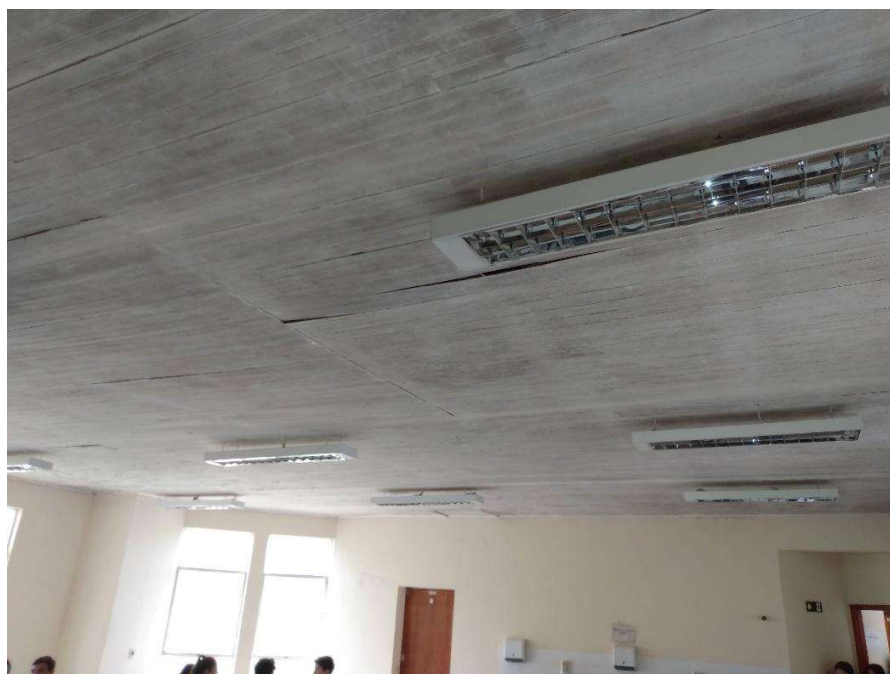
Foto 2 – Forro de madeira do refeitório
